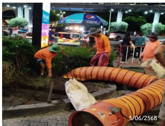
รูปที่ 2-20 การตรวจสอบและทำความสะอาดบ่อพักน้ำ
