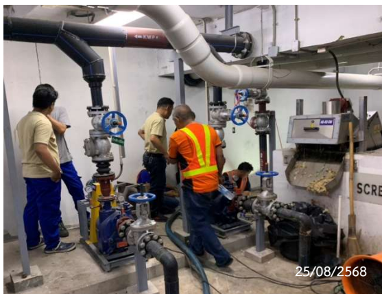
รูปที่ 2-16 เจ้าหน้าที่ตรวจสอบและซ่อมบำรุงระบบบำบัดน้ำเสีย
