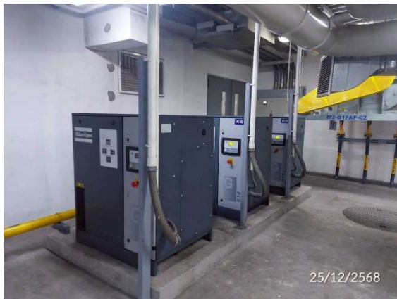
ระบบอัดอากาศ (AIR BLOWER)
