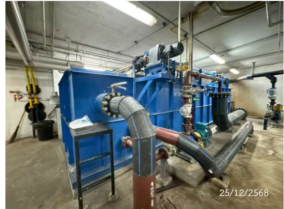
ถังเติมอากาศ (DAF TANK)
