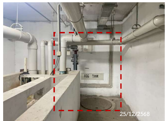
ถังดักกากไขมัน (FOG TANK)
