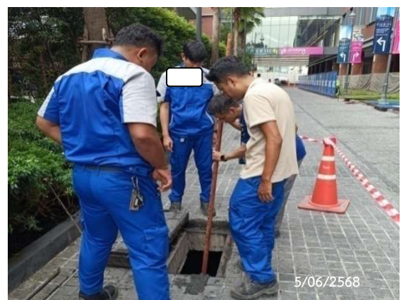
รูปที่ 2-20 การตรวจสอบและทำความสะอาดบ่อพักน้ำ
