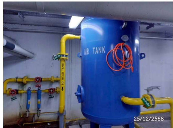
ถังอัดอากาศ (AIR TANK)
