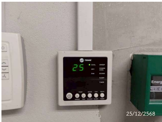
รูปที่ 2-30 ระบบอิเล็กทรอนิกส์เทอร์โมสตัทของระบบปรับอากาศ
